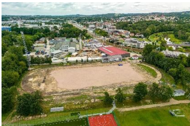
Zdjęcie przedstawia modernizowany Stadion Miejski w Skawinie.
