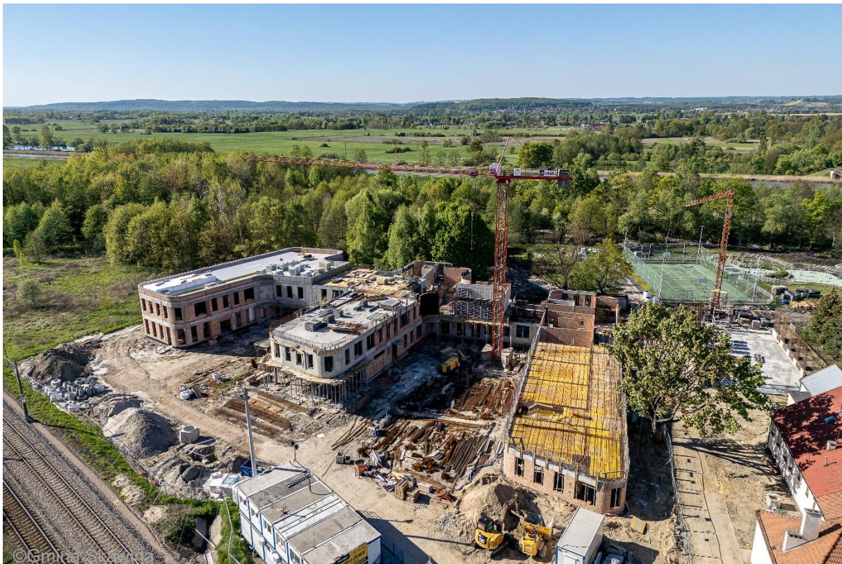
Zdjęcie przedstawia budowę Zespołu Placówek Oświatowych w Wielkich Drogach.
