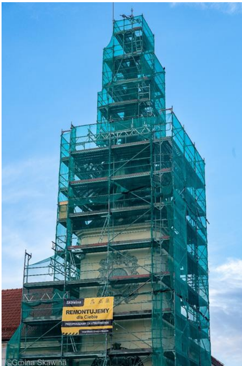
Zdjęcie przedstawia wieżę skawińskiego Ratusza podczas remontu.
