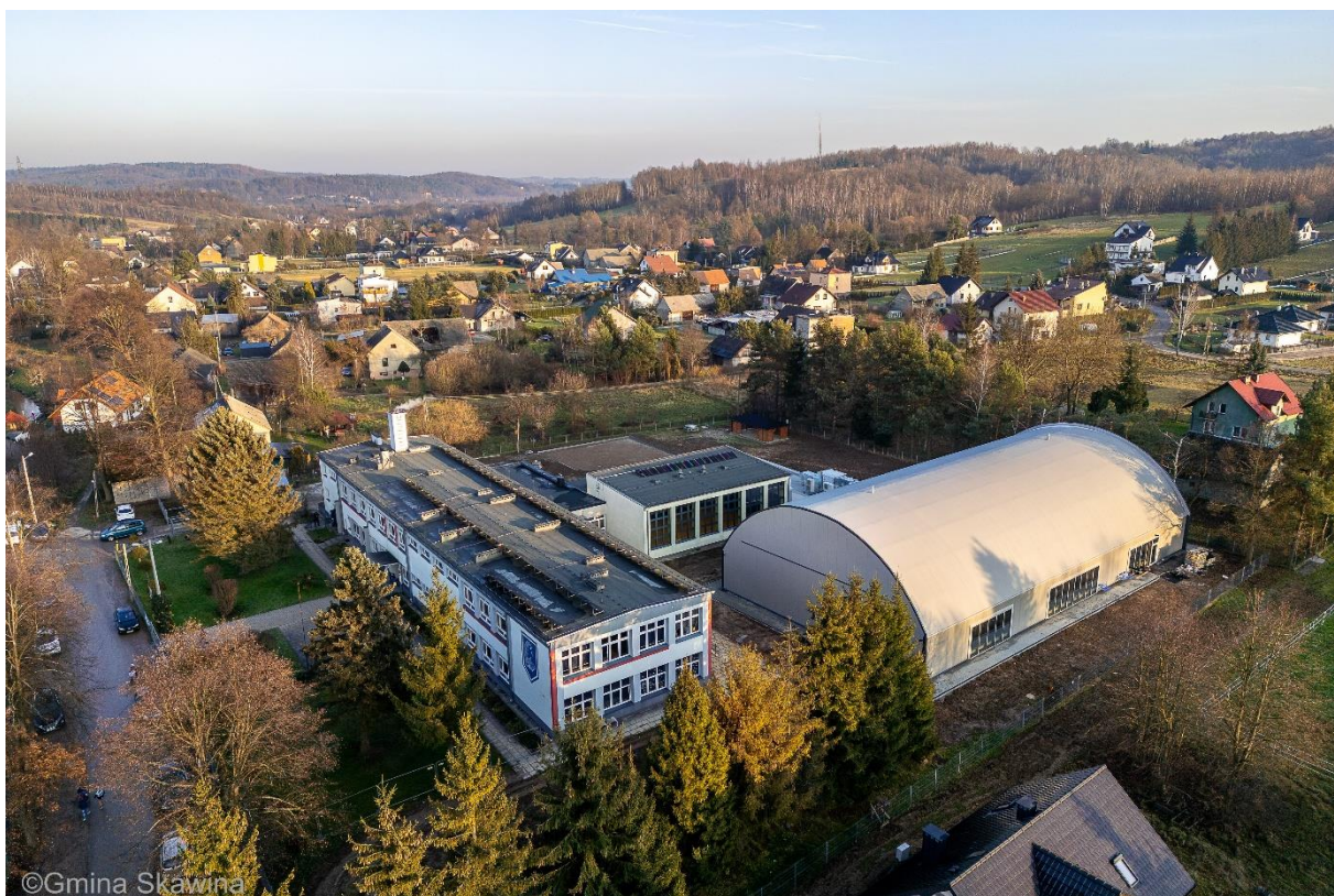
Zdjęcie nowo wybudowaną halę sportową przy SP w Woli Radziszowskiej.
